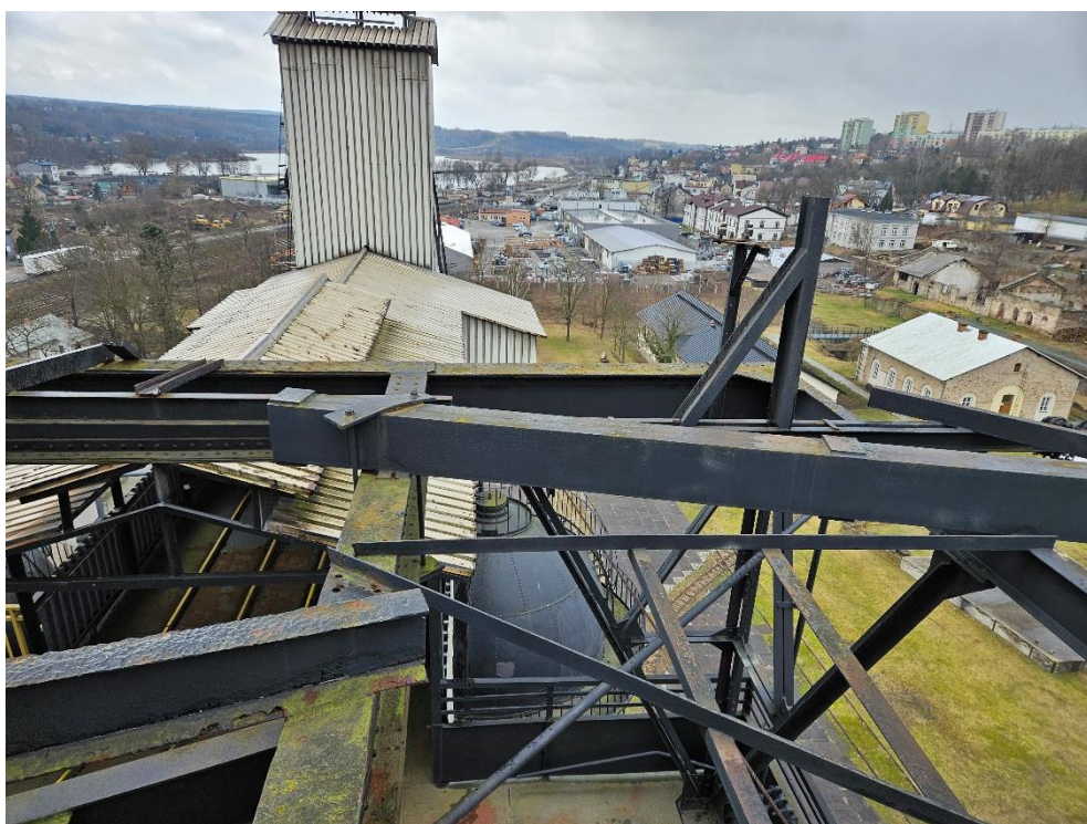
Fot. 21. Stan konstrukcji ramowej nad dzwonem Langena
