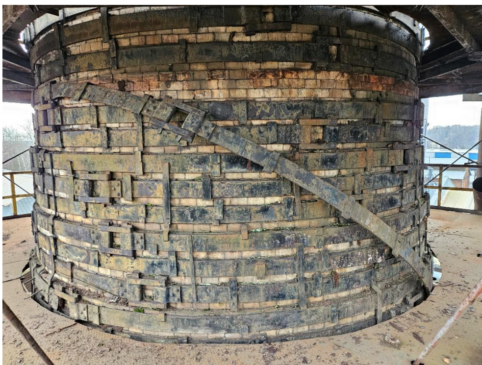
Fot. 7. Skorodowane i popękane klamry ściągow
