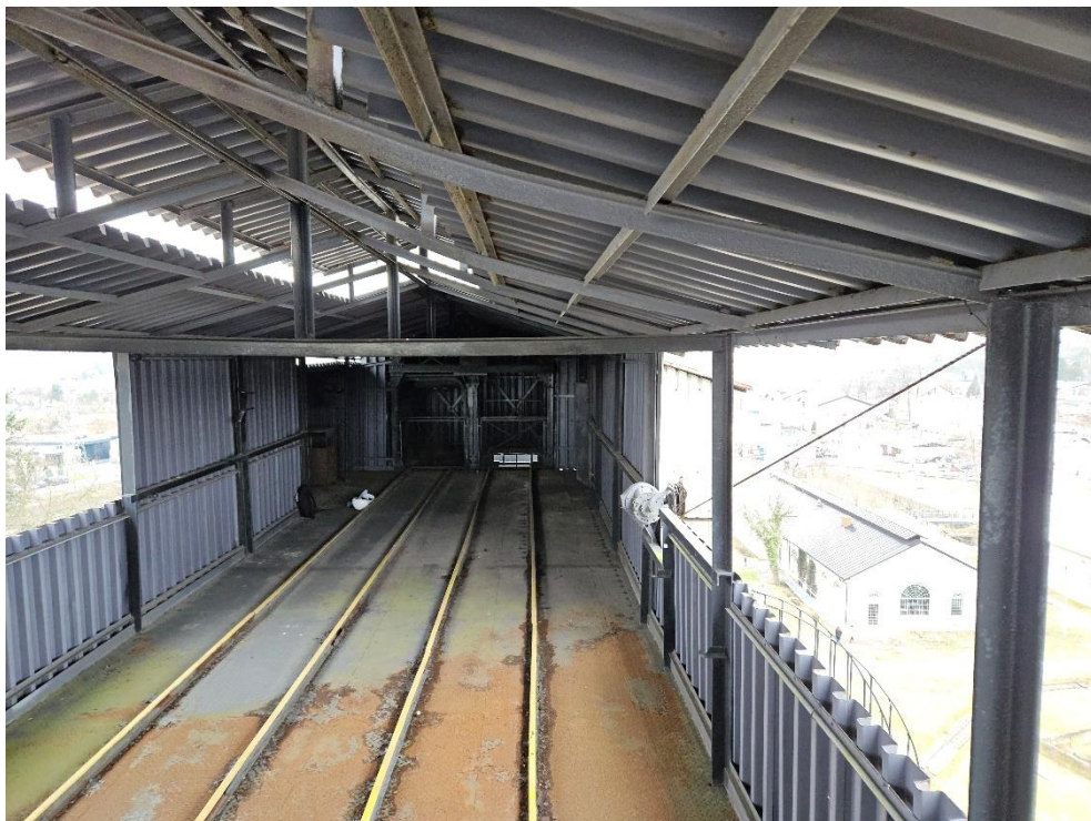
Fot. 28. Odkształcone elementy stalowe zadaszania pomostu pomiędzy wieżą wyciągową i Wielkim Piecem
