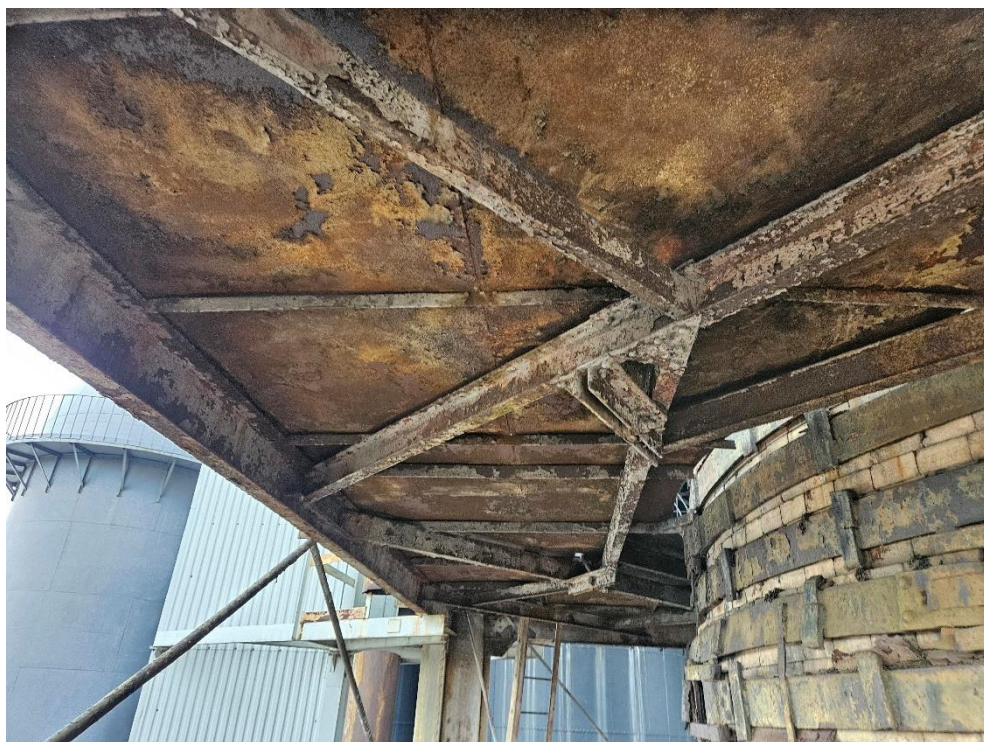
Fot. 16. Stan konstrukcji nośnej pomostu
