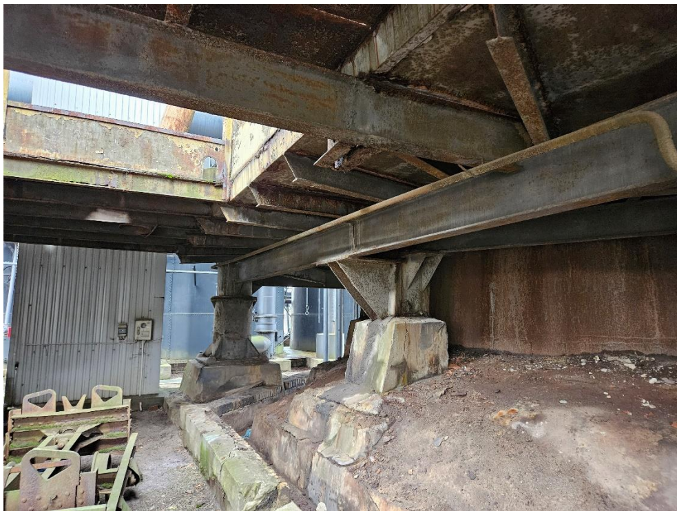
Fot. 4. Spękany fundament słupa wsporczego
