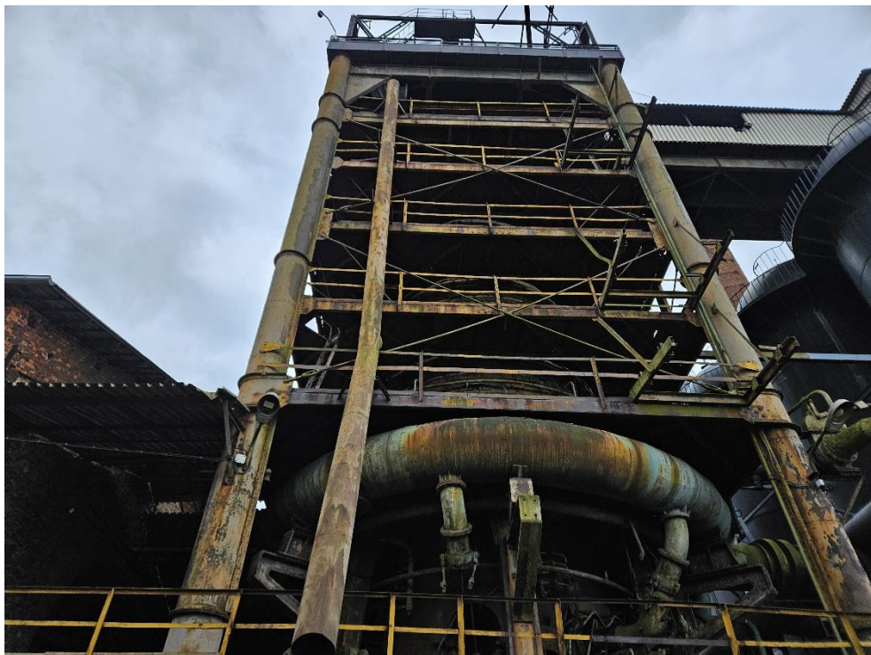
Fot. 6. Korozja konstrukcji nośnej
