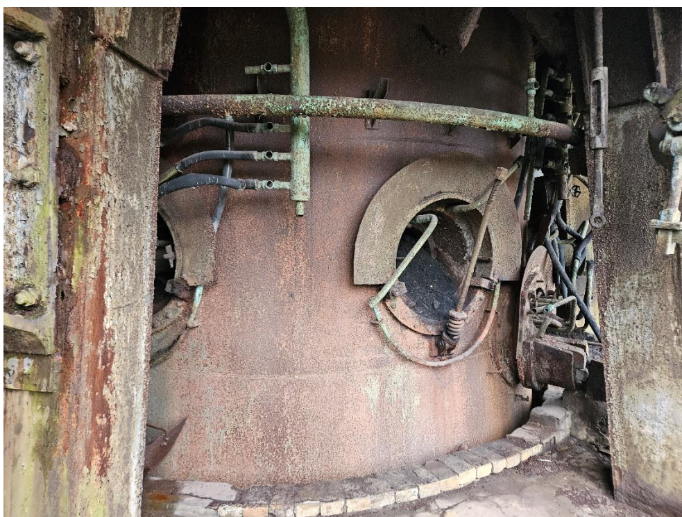
Fot. 9. Korozja blach gara Wielkiego Pieca
