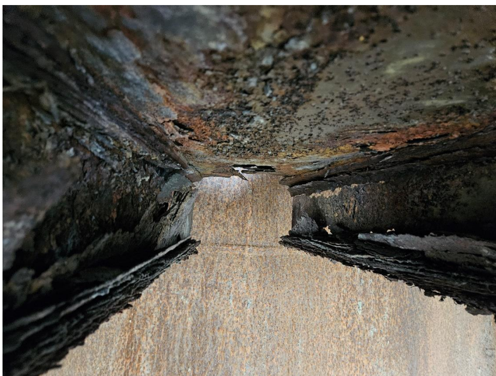
Fot. 13. Korozja belek podpierających pomost na poziomie \pm 0,00
