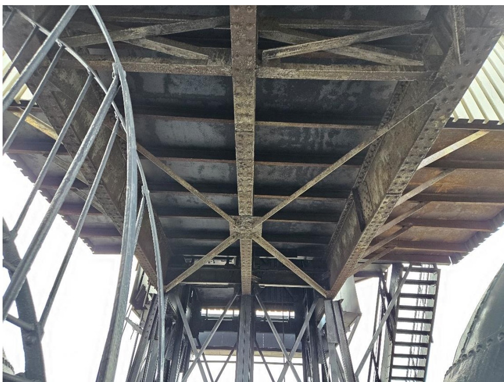
Fot. 25. Stan konstrukcji pomostu pomiędzy wieżą wyciągową i Wielkim Piecem
