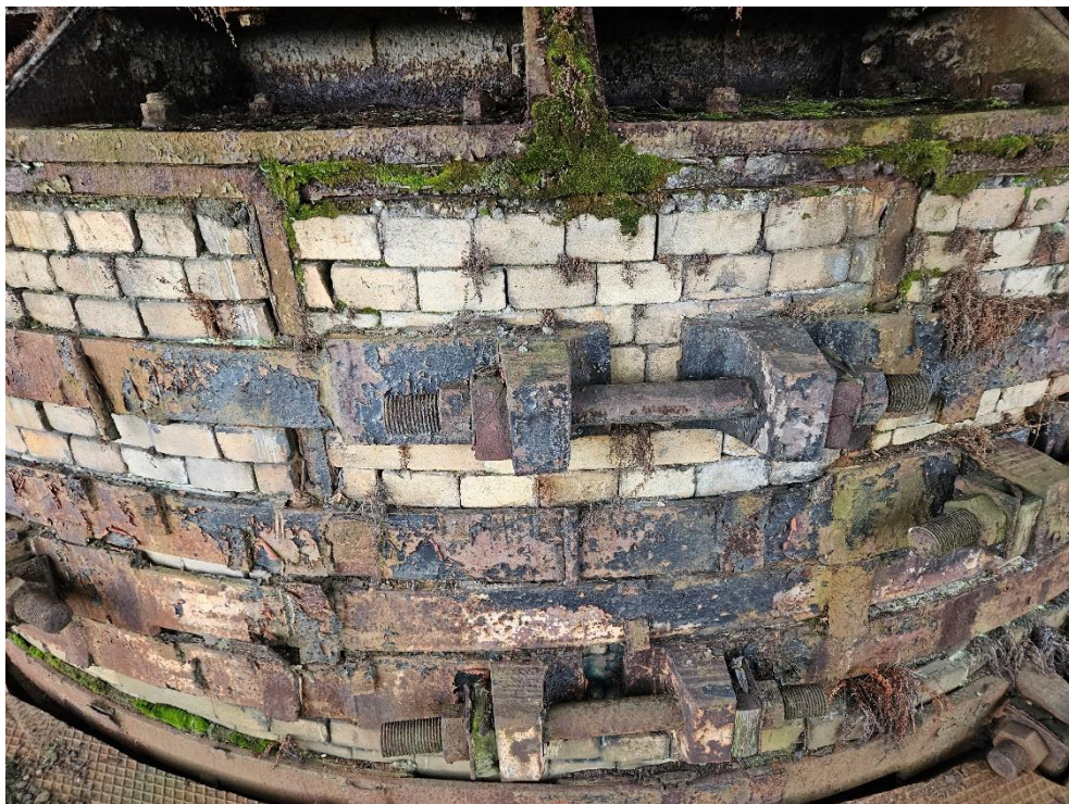
Fot. 8. Korozja biologiczna trzonu Wielkiego Pieca
