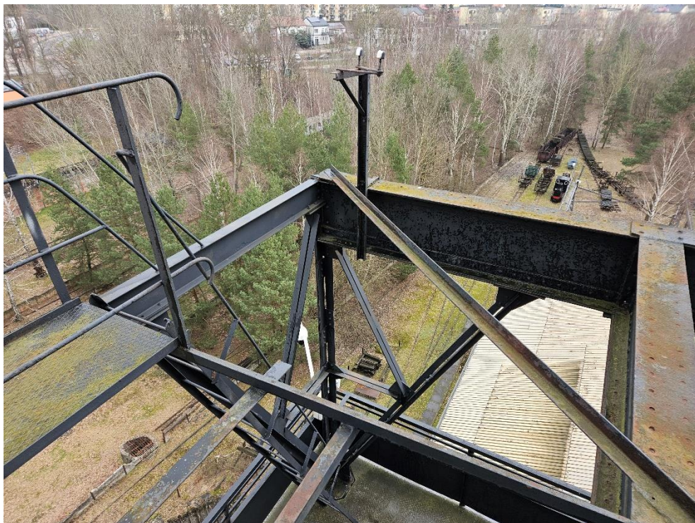
Fot. 22. Stan konstrukcji ramowej nad dzwonem Langena
