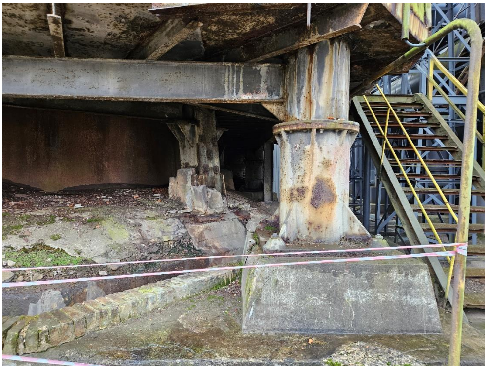
Fot. 2. Znaczny ubytek betonu w dolnej części słupa wsporczego
