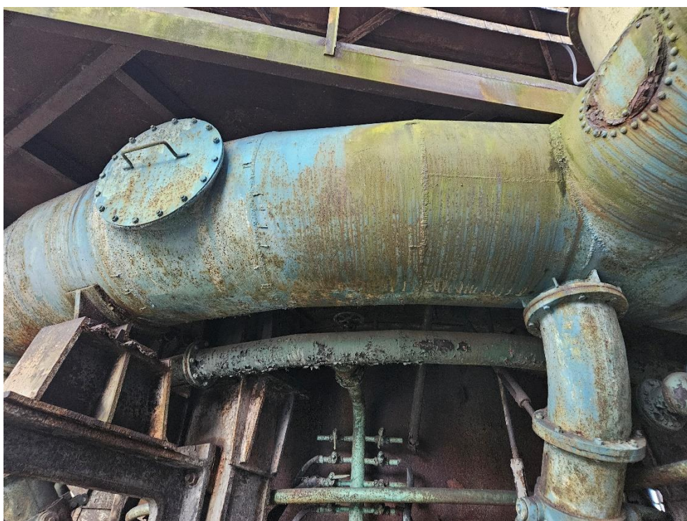
Fot. 31. Korozja orurowania okężnic dmuchu
