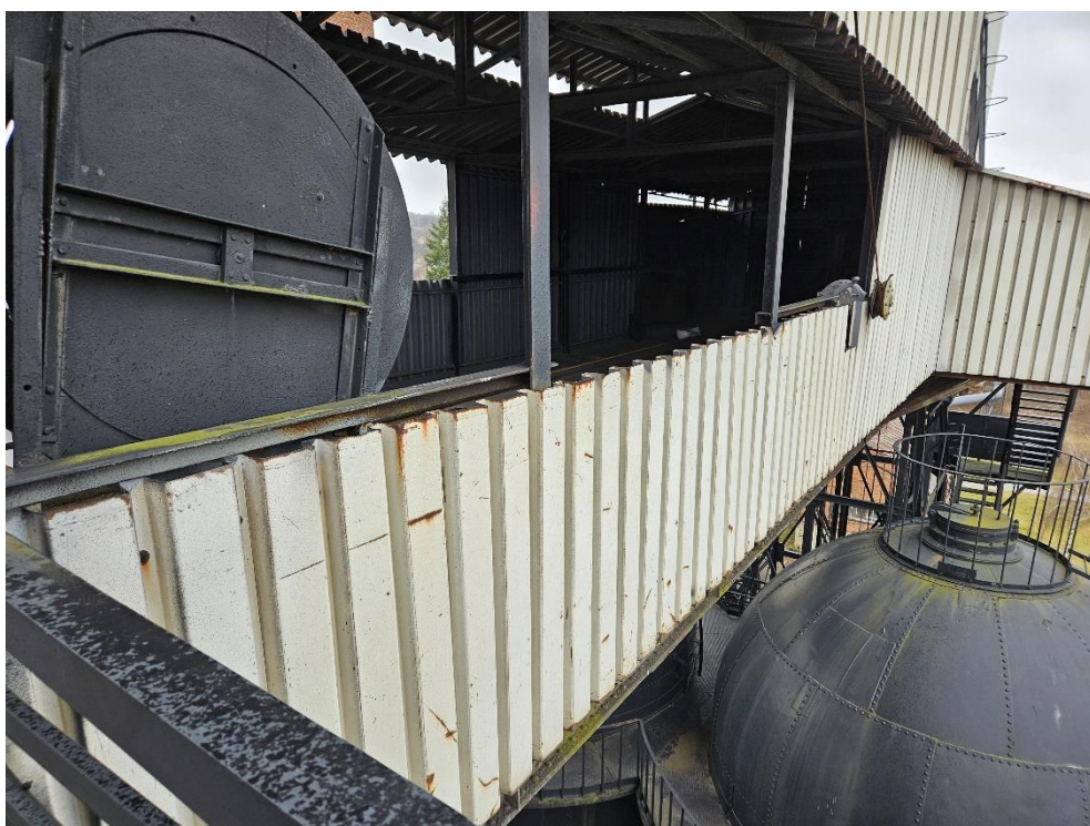
Fot. 29. Stan blachy trapezowej pomostu pomiędzy wieżą wyciągową i Wielkim Piecem
