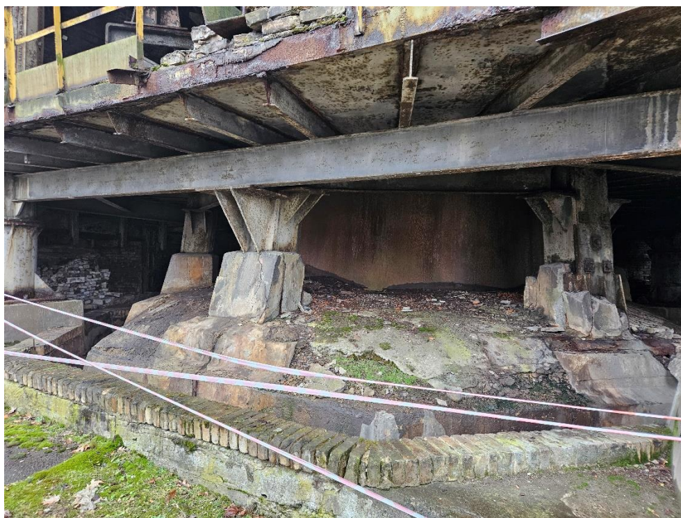
Fot. 1. Ogólny stan konstrukcji fundamentu Wielkiego Pieca
