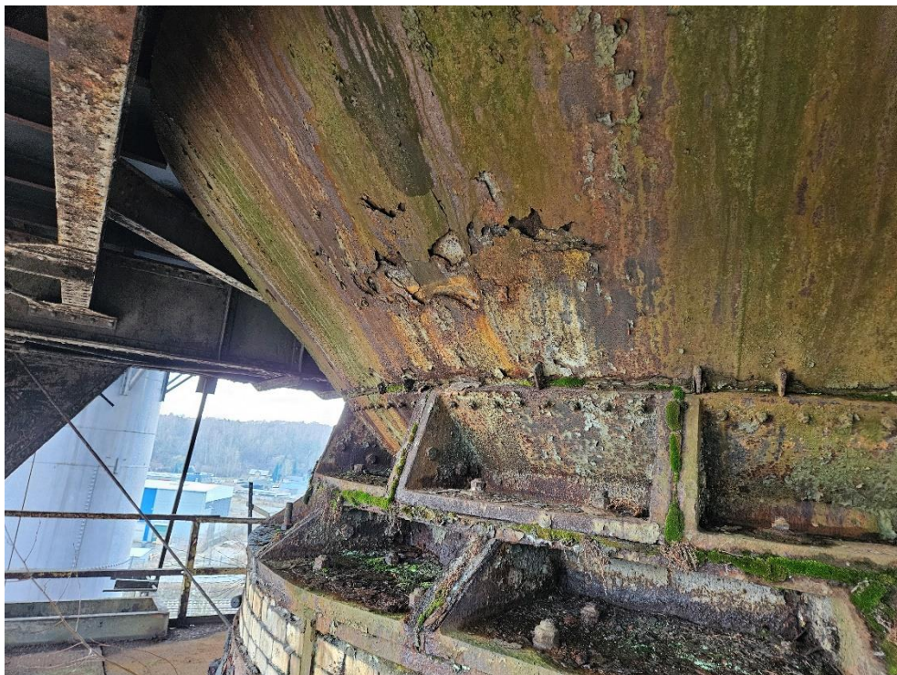
Fot. 10. Korozja blach leja Wielkiego Pieca
