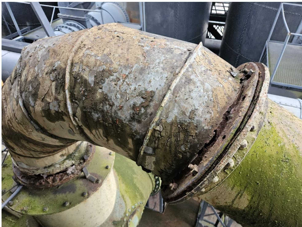
Fot. 30. Korozja elementów orurowania instalacji Wielkiego Pieca
