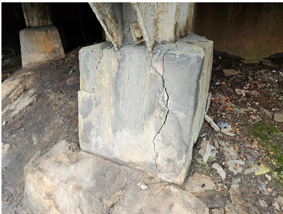
Fot. 3. Spękany fundament słupa wsporczego
