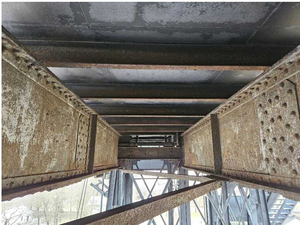
Fot. 26. Stan konstrukcji pomostu pomiędzy wieżą wyciągową i Wielkim Piecem
