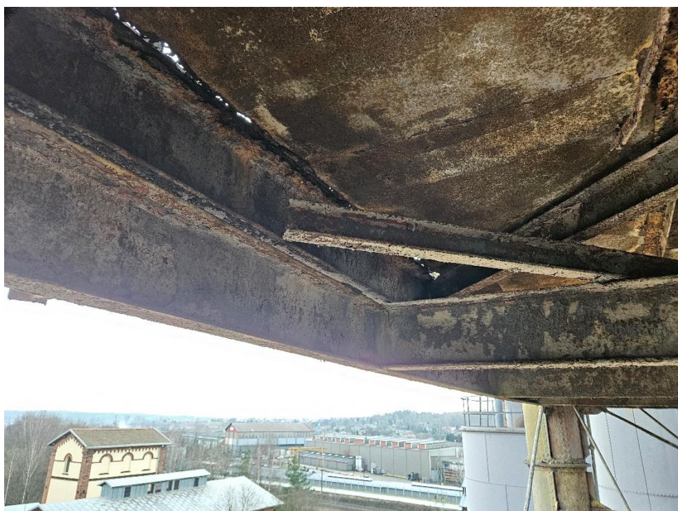
Fot. 17. Stan konstrukcji nośnej pomostu
