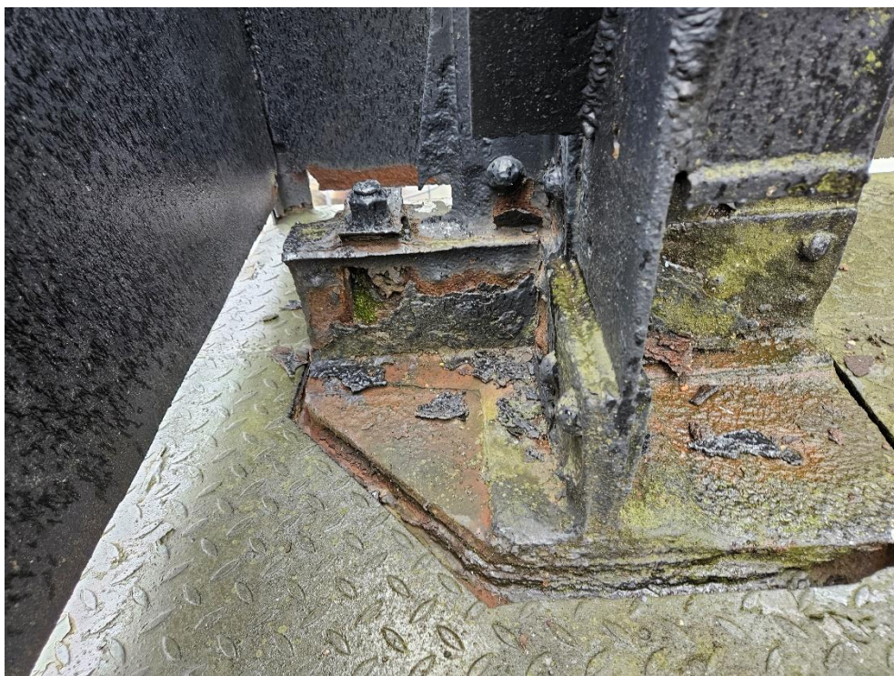
Fot. 23. Korozja podstawy słupa
