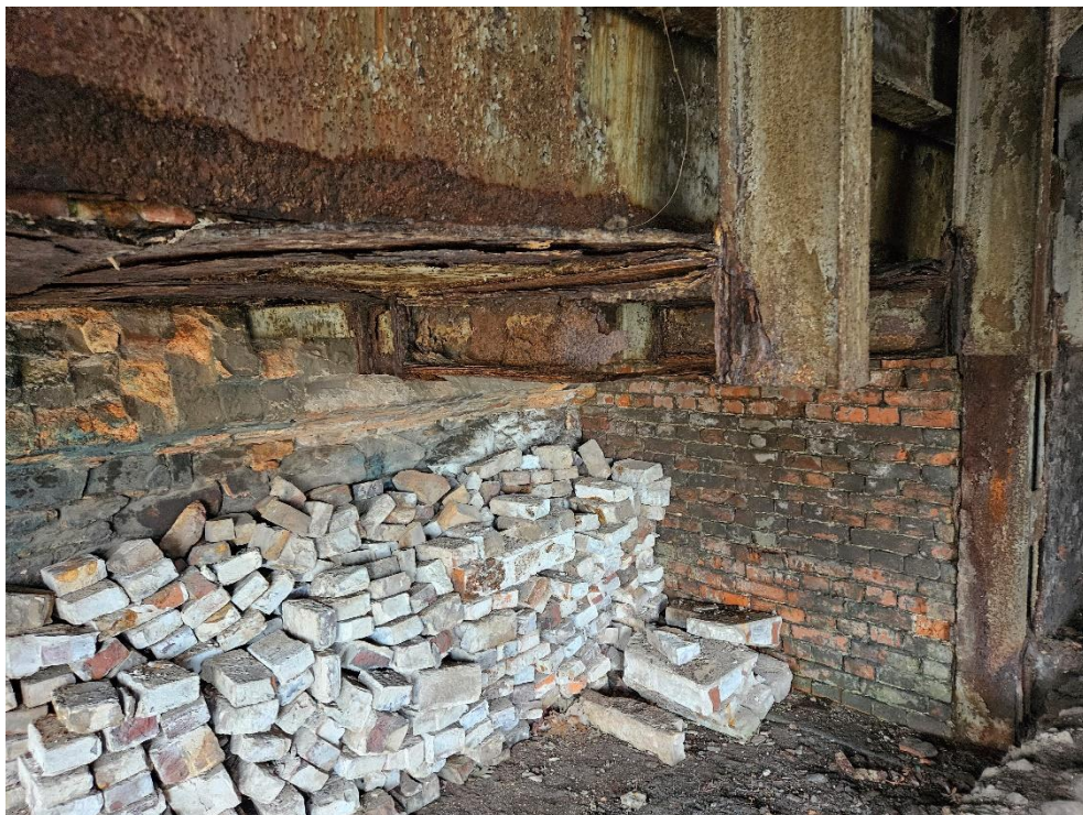
Fot. 12. Korozja belek podpierających pomost na poziomie \pm 0,00
