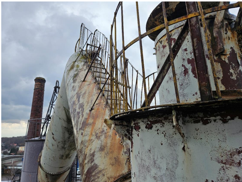
Fot. 20. Stan rurociągu odpylenia
