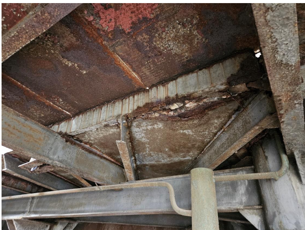
Fot. 11. Stan konstrukcji pomostu na poziomie \pm 0,00
