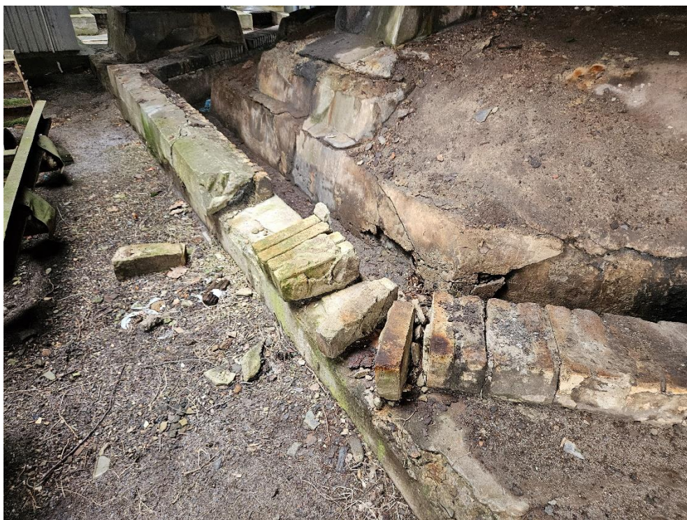
Fot. 5. Cokoły okalające kanał zdewastowane, pozbawione wymurowanych szczytów
